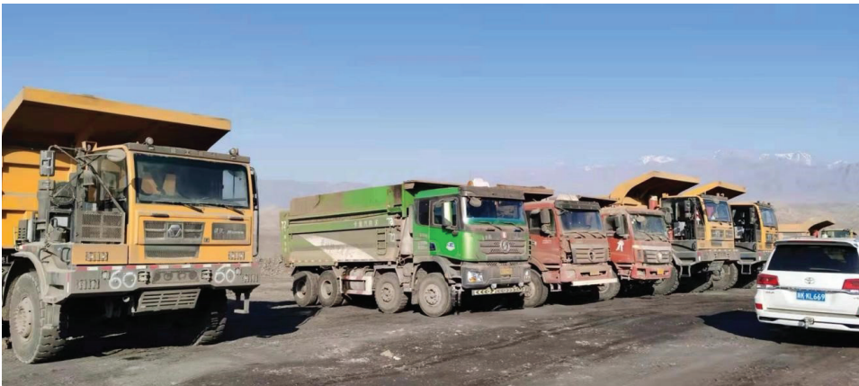
星亮礦的施工隊伍與施工機械
