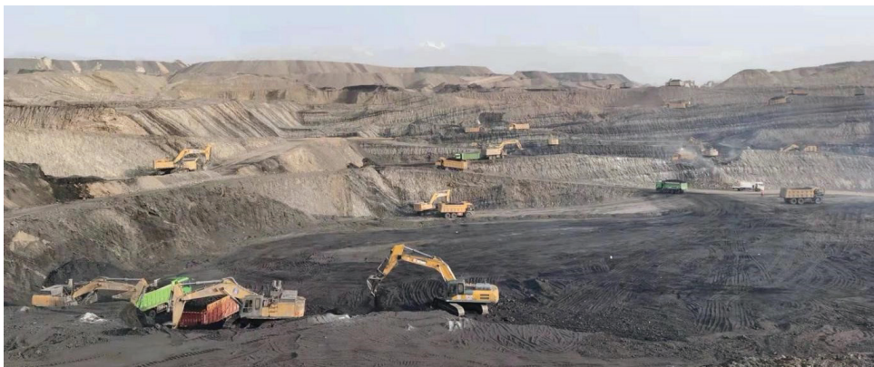
施工團隊進行挖土及撥離工作
