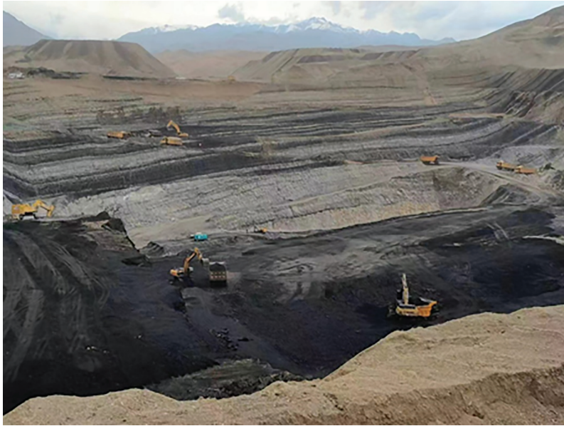
施工團隊進行挖土及撥離工作
