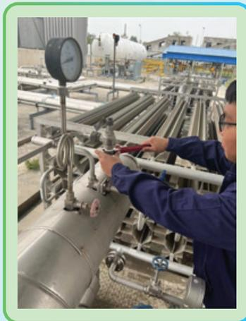
穩定供氣是本集團對客戶的服務承諾，我們一直與大型供應商保持良好關係，為我們保持穩定的LNG提供重要保障，以及減低供應鏈斷貨的風險。另外，本集團十分重視於LNG氣站內的管理及營運，確保用戶能使用既安全又優質的燃氣。我們會安排氣站員工在供暖期24小時駐守，監測氣站運作。氣站在不同位置設有開關閥系統，當管道有破損時能透過系統自動感應管道內的氣壓轉變，從而觸發警報系統通報氣站職員以進行搶修。我們亦定期檢查氣站設備，確保所有設備的狀態符合標準。
