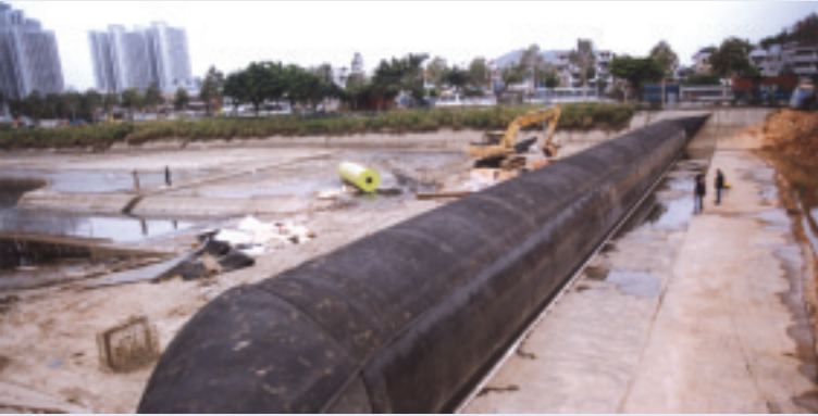
新界北區之渠務維修保養及建造工程（2000-2002）
