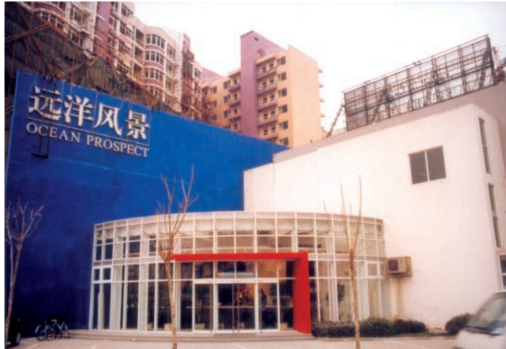
位於北京的遠洋風景住宅發展項目
