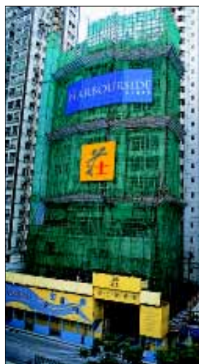
北角莊士維港軒 (建築工程進行中)
