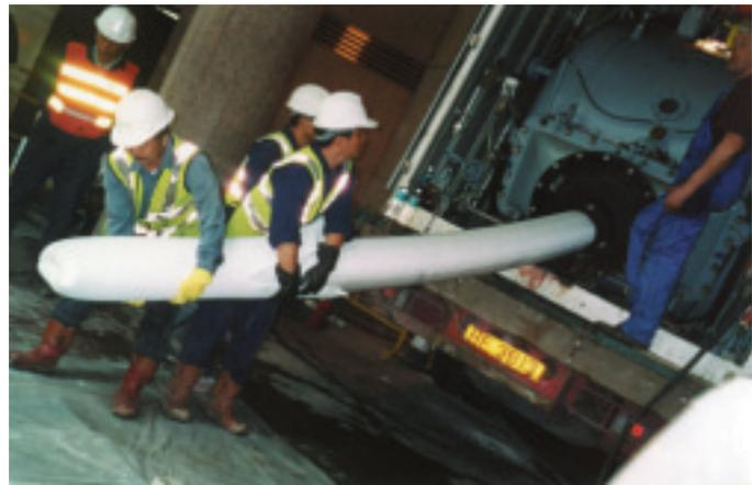
於中環永安大廈採用非開挖套管補喉技術進行修補地下冷卻水管工程
