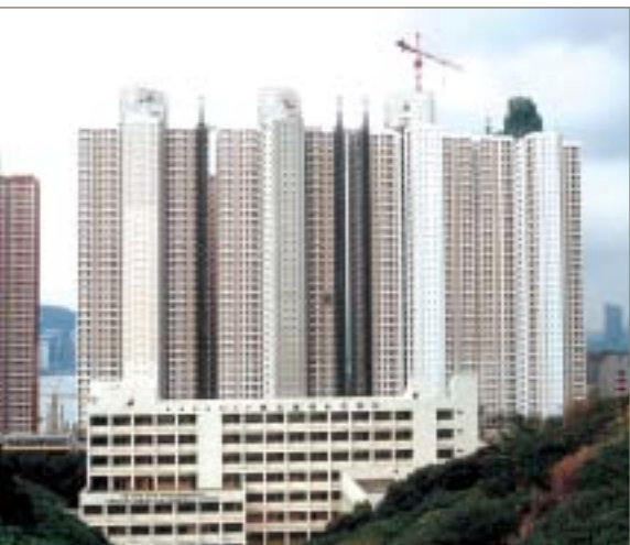
油塘邨重建第五期工程曾榮獲多項工地安全及環境管理獎項
