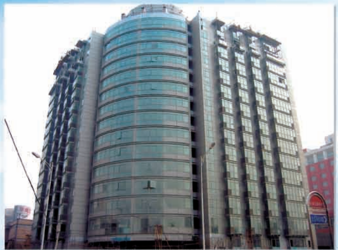
西單項目九號地上興建的住宅大廈
