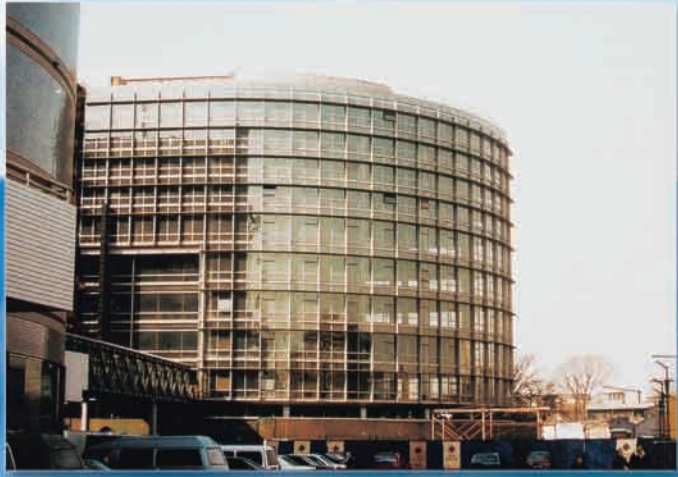
西單項目一號地上興建的 商業大廈
