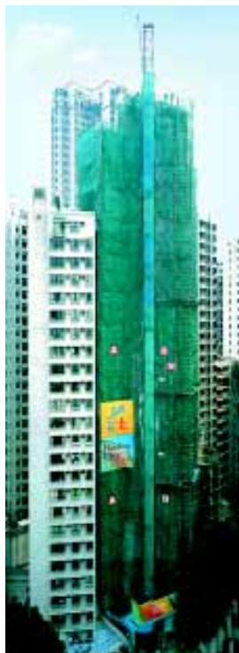
半山莊士明德軒 (建築工程進行中)
