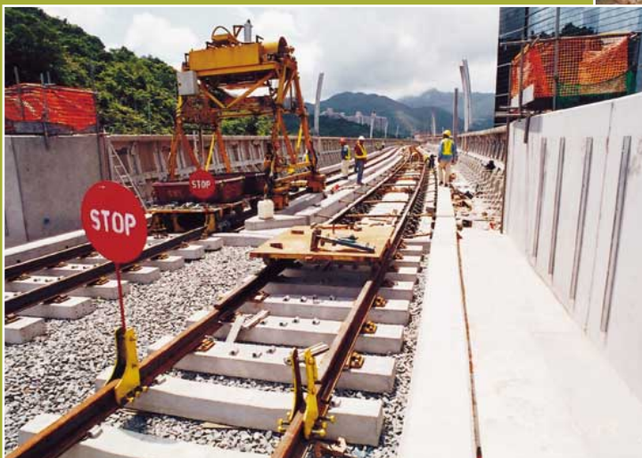
東鐵支線路軌工程
