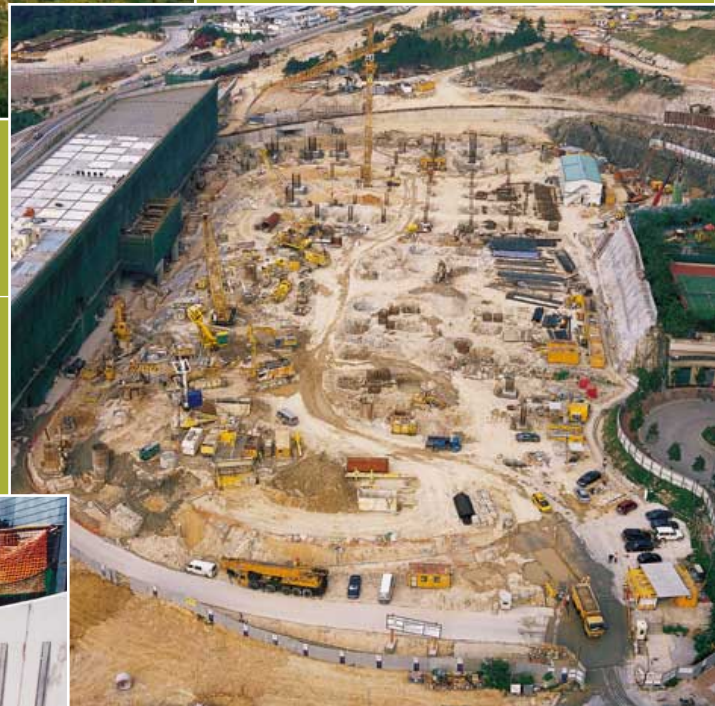
烏溪沙車站公共交通工具交匯處建築工程
