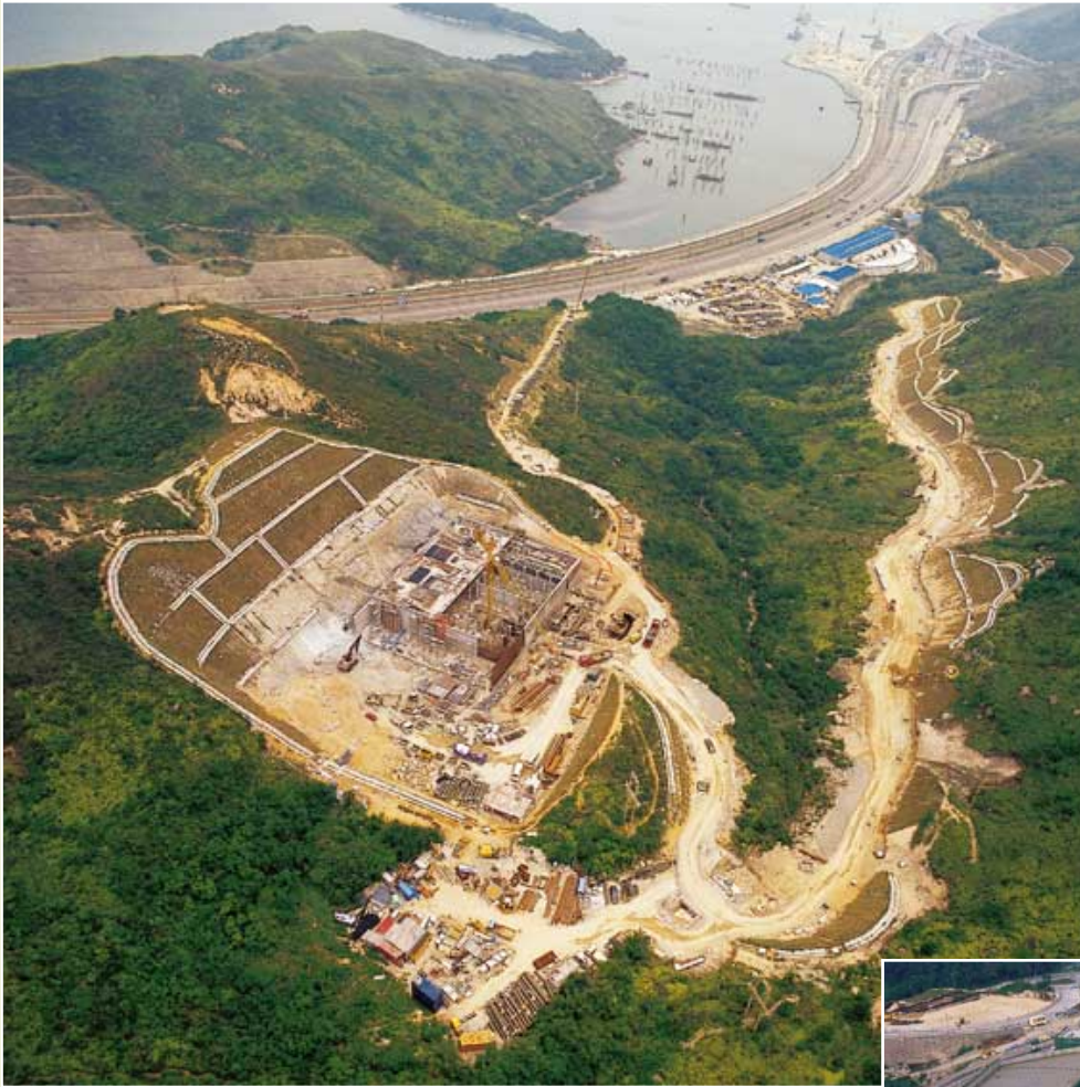
陰澳篤食水配水庫建築工程
