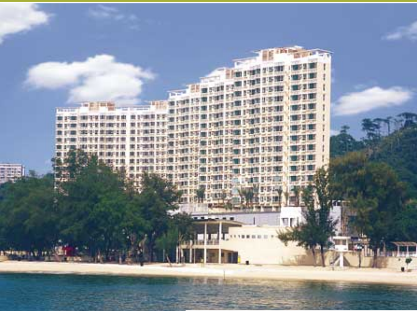
屯門市地段386號翠濤居建築工程
