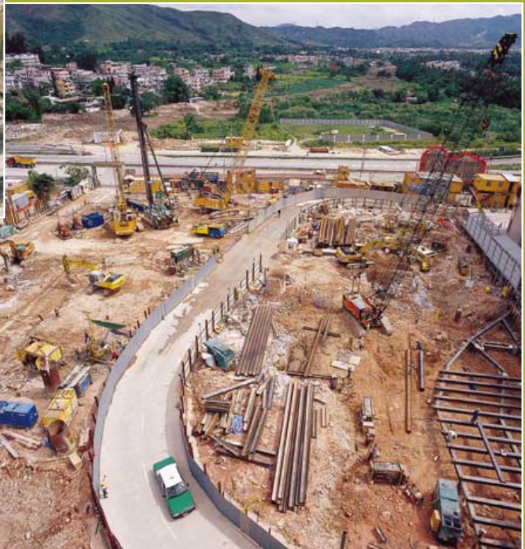
元朗博愛醫院重建項目地盤開拓及地基工程
