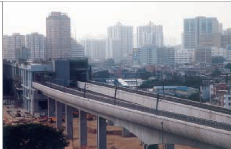
九鐵西鐵(元朗站)
