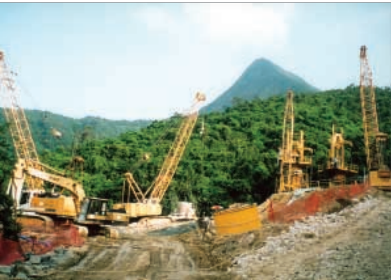
新界馬鞍山T7道路工程(鑽孔樁工程)
