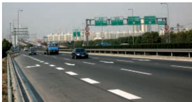
Shanghai Huqingping Expressway II 上海滬青平公路二期
