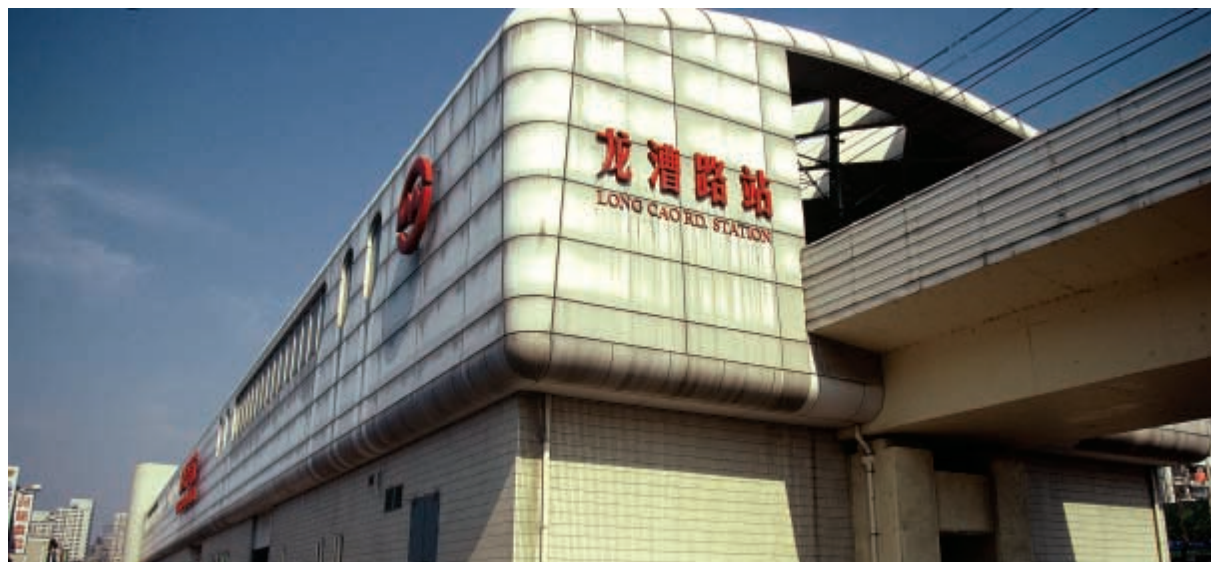
Shanghai Subway Mingzhu Line 上海地鐵，明珠綫
