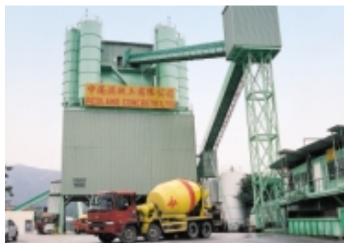
本集團位於香港元朗的混凝土攪拌站 Our concrete batching plant in Yuen Long, Hong Kong
