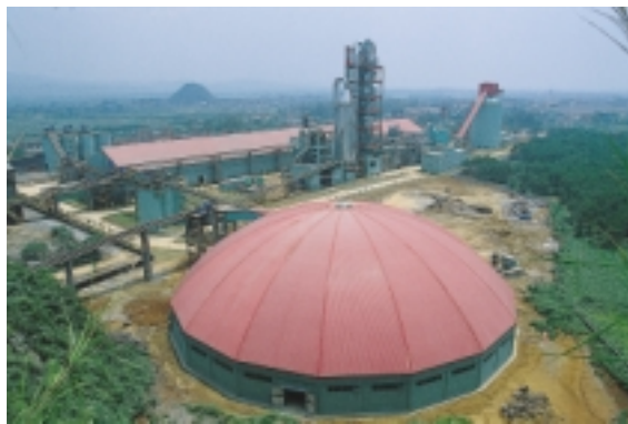
本集團位於廣西的新型乾法水泥生產線 Our NSP cement production line in Guangxi ZAR
