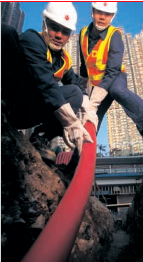
港燈在輸電網上鋪設新電纜，不斷強化供電系統，以應付新用戶的電力需求。
