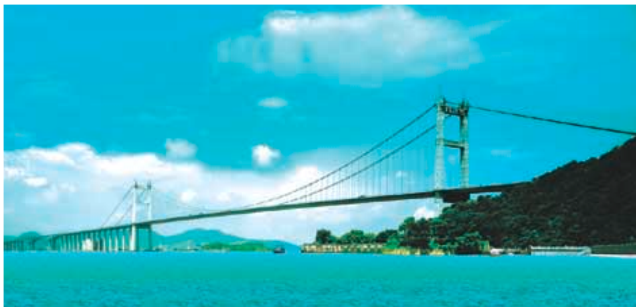
連接珠江三角洲東西岸的虎門大橋
