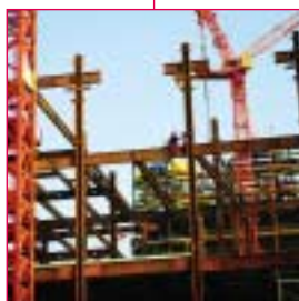
建築 基建及建築之基礎
