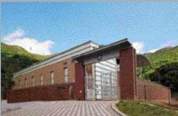
愉景灣之中華電力變電站 CLP Power Substation at Discovery Bay
