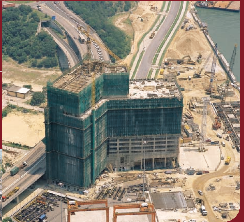
青衣市地段139號辦公樓建築工程
