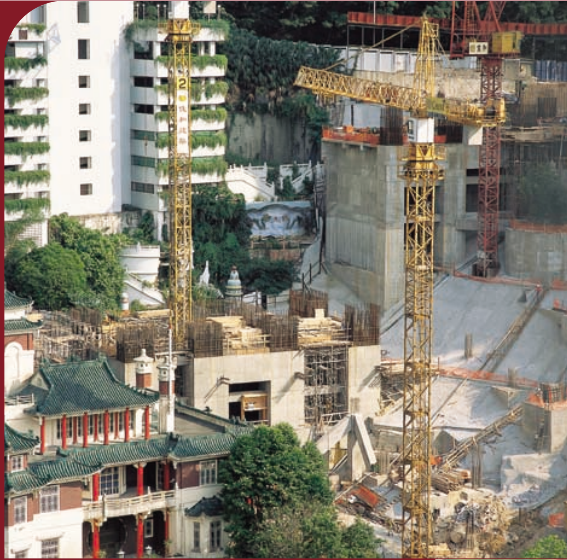
大坑住宅發展建築工程
