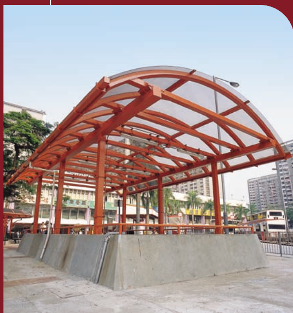
香港房屋委員會保養工程
