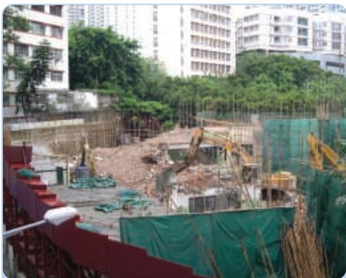
九龍鑽石山蒲崗村道97號正進行拆卸工程
