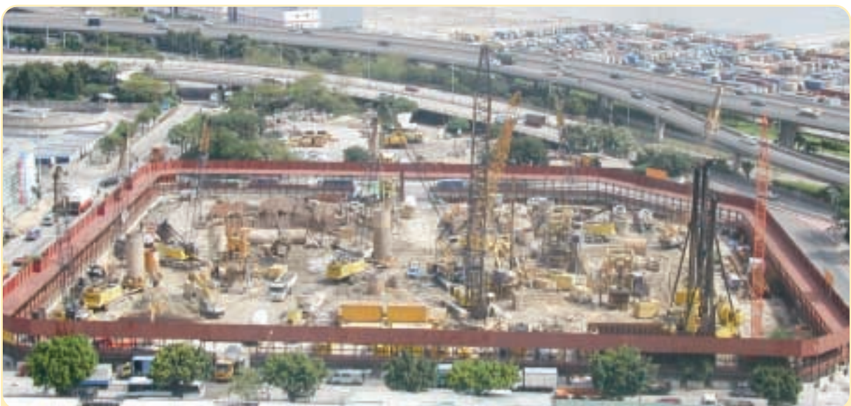
於九龍九龍灣九龍內地段5927號貿易廣場第5期之鑽孔灌注樁工程
