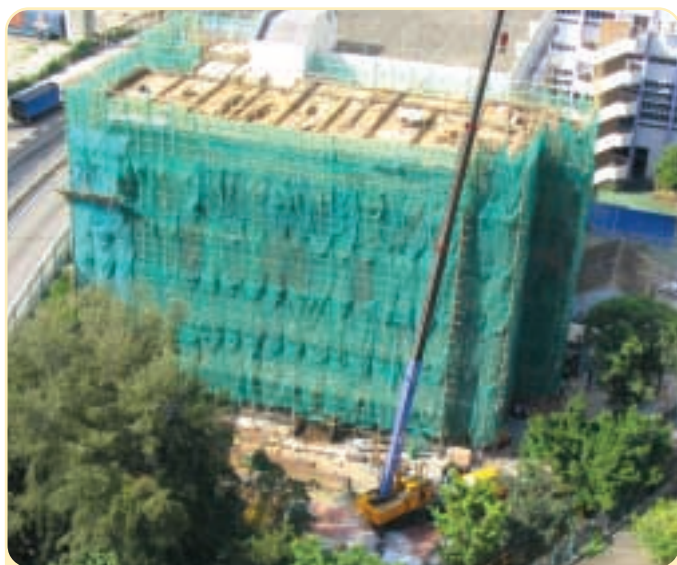
於新界葵涌荔景邨荔景天主教中學之上蓋工程
