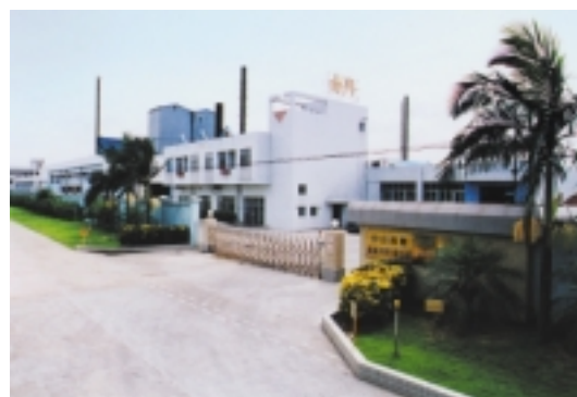
位於中國中山之工業積層板廠房之正門
