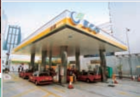
易高 — 石油氣加氣站
