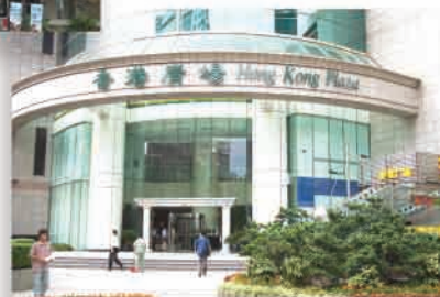
香港廣場 — 辦公樓正門
