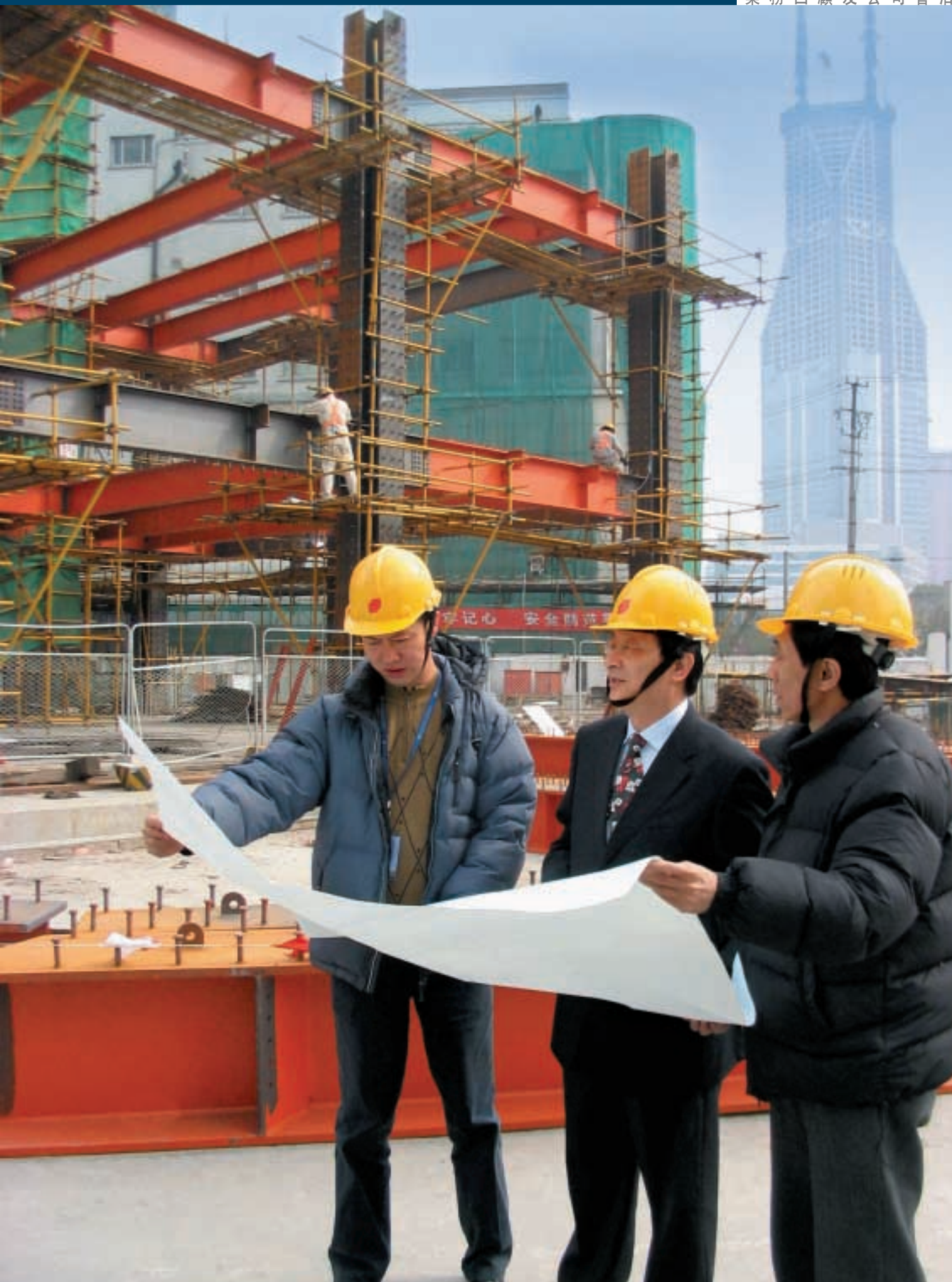
建築地盤現況
