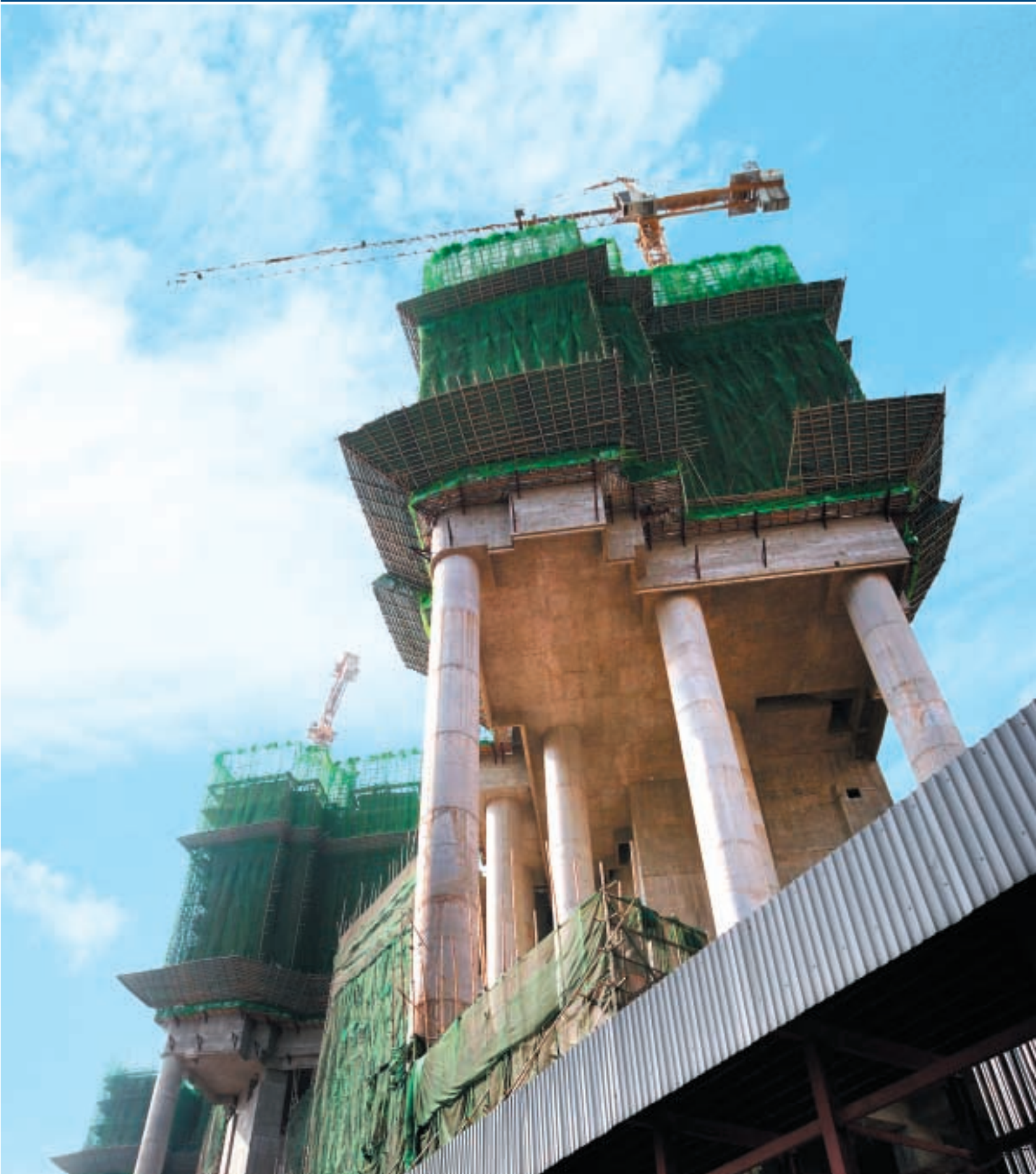
舊車廠地皮正重建為多幢豪華住宅
