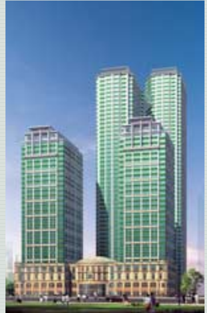
武漢時代廣場預計於二〇〇七年第四季竣工。
