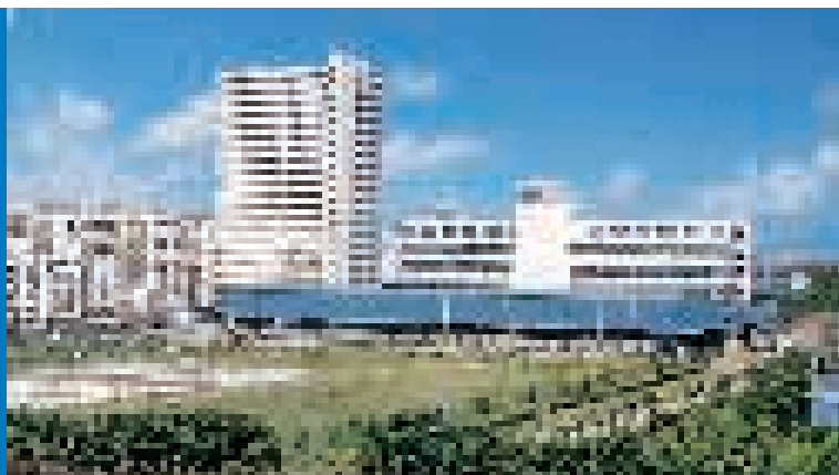
深圳生產綜合大樓
