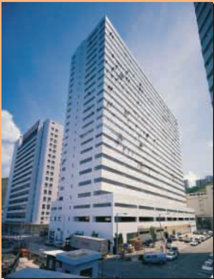
香港鴨脷洲港灣工貿中心
