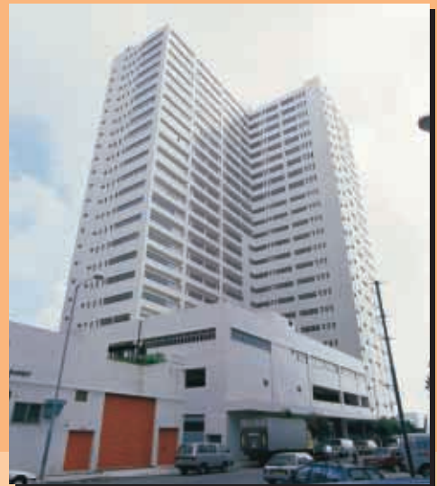
香港鴨脷洲海灣工貿中心
