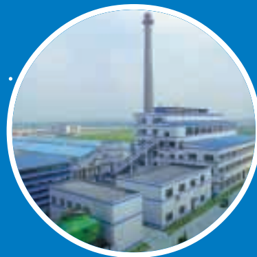
熱電聯產發電站
