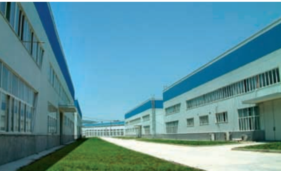
安徽部份廠房外貌
