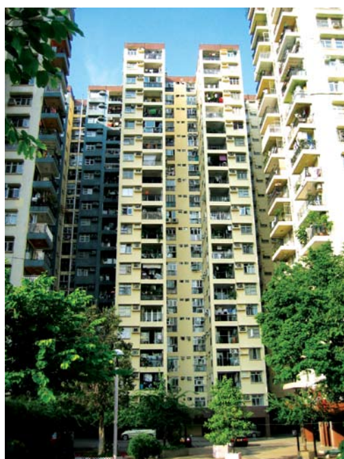
◀ External wall renovation works for Mei Foo Sun Chuen 美孚新村外牆維修工程
