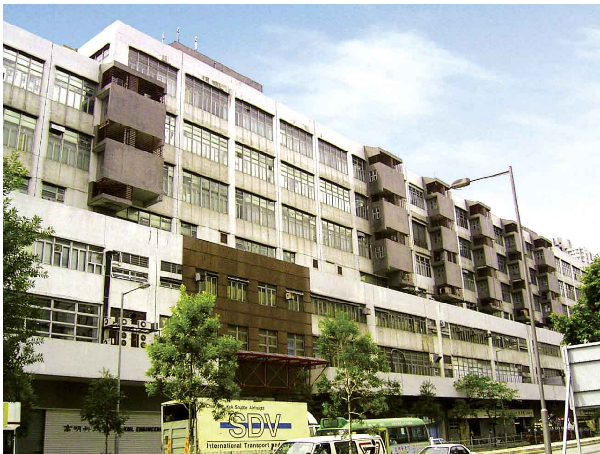
▲ Shatin Industrial Centre 沙田工業中心
