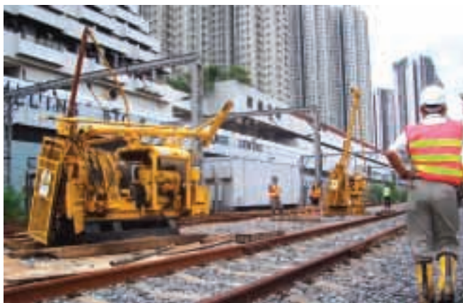
鐵達地質工程有限公司承建九廣鐵路何東樓(地盤A)之鑽探工程
