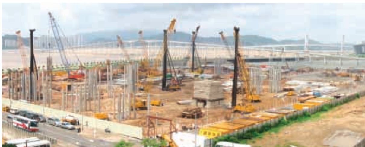
建業天威建築(澳門)有限公司及建榮工程(澳門)有限公司承建位於澳門南灣美高梅金殿之大同樁及鋼板樁
