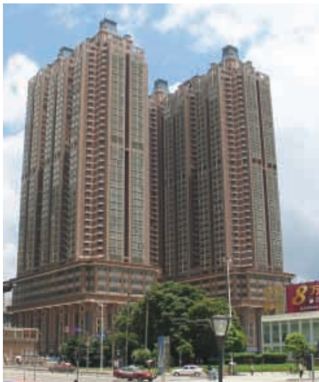
由漢國置業有限公司發展位於中國廣東省深圳市羅湖區嘉賓路之城市天地廣場
