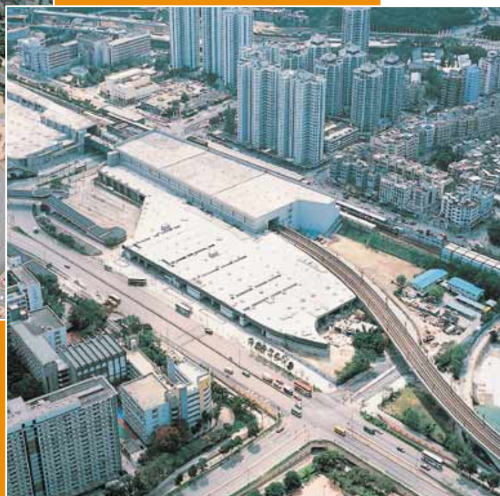
大圍車站公共交通工具 交匯處建築工程
