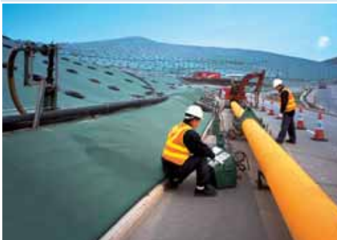
鋪設連接新界東北堆填區與大埔煤氣廠之管道
