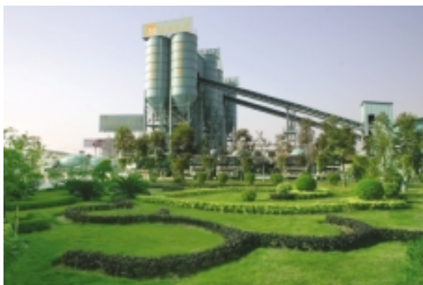
本集團位於東莞的混凝土攪拌站 Our concrete batching plant at Dongguan
