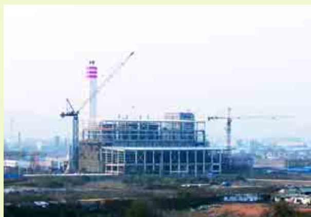
蘇能垃圾焚燒發電廠(主廠房在建中)
