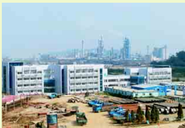
蘇能垃圾焚燒發電廠(生活樓在建中)
