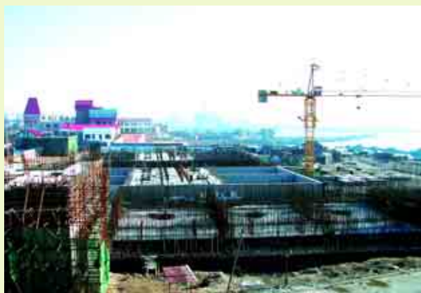
青島麥島污水處理廠(擴建工程進行中)
