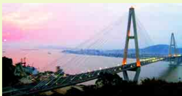
福州青洲大橋 Fuzhou Qingzhou Bridge
