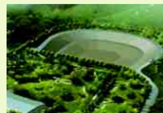
工業固體廢物安全填埋項目 Disposal centre for industrial solid waste
