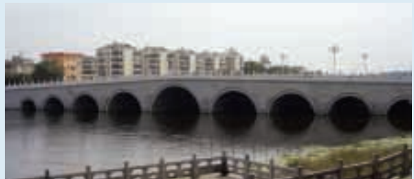
徐州和平橋 Xuzhou Heping Bridge
