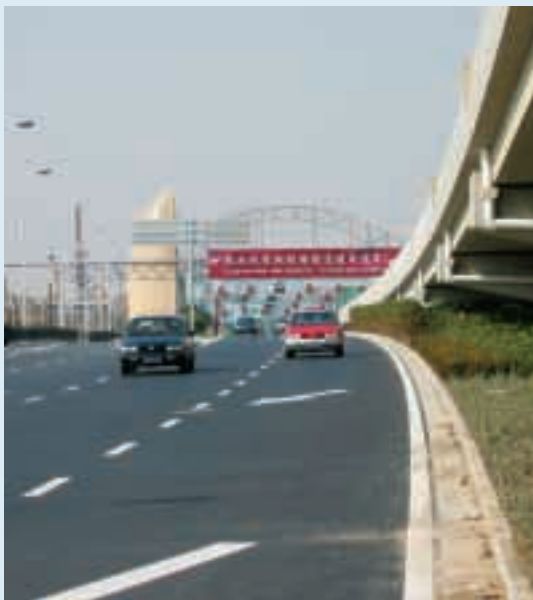
五洲大道 Wuzhou Avenue
