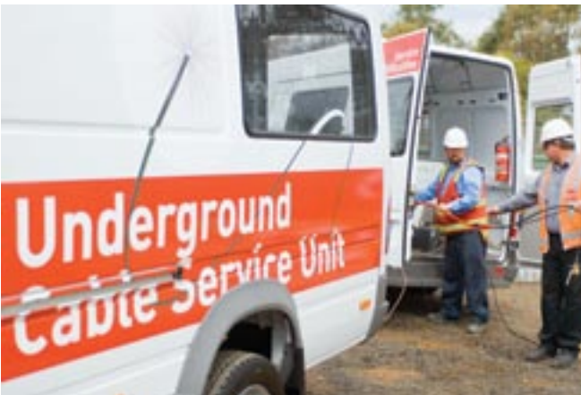
CitiPower及Powercor率先引入可準確偵測地下故障位置的技術，盡量縮小修理電纜所需挖掘的面積。
