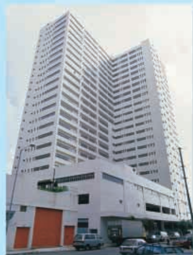
香港鴨脷洲海灣工貿中心
