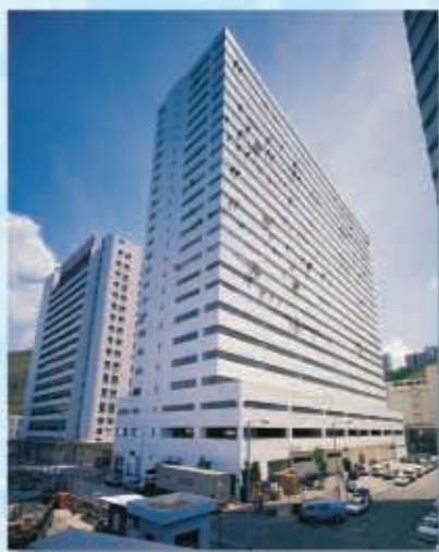
香港鴨脷洲港灣工貿中心
