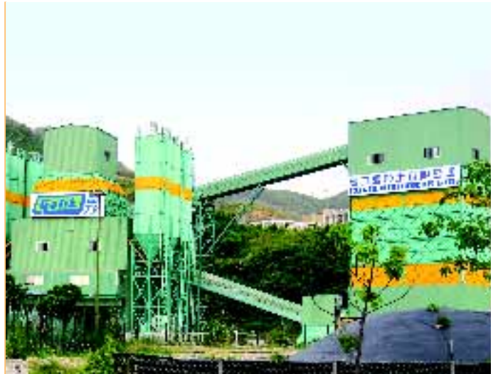
位於香港大嶼山小蠔灣之混凝土廠
