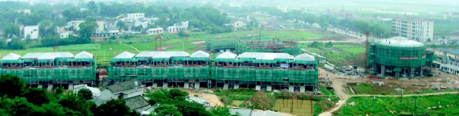
長沙比華利山第一期(施工中)
