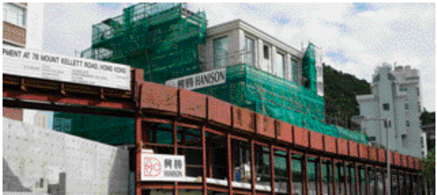
► Residential development at Mount Kellett Road 位於加列山道之住宅發展項目
