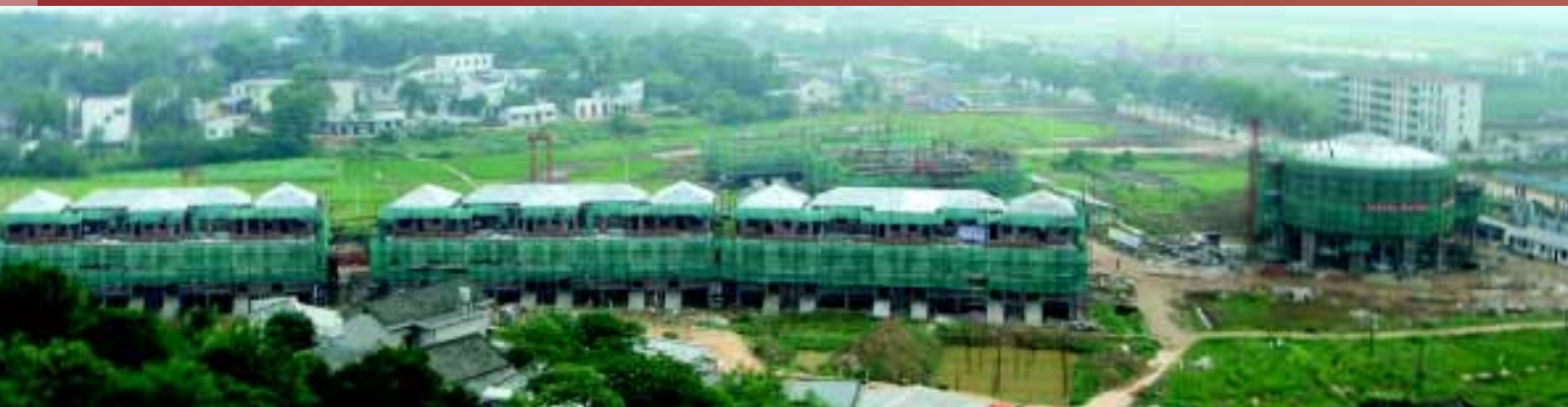
長沙比華利山第一期（施工中）
